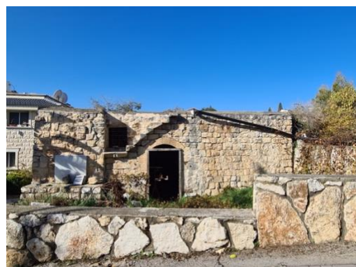
Ny og gammel bebyggelse i Miilya. Alle gamle hus hadde flate tak og en utvendig trapp i stein som var bygget inn i vegg
